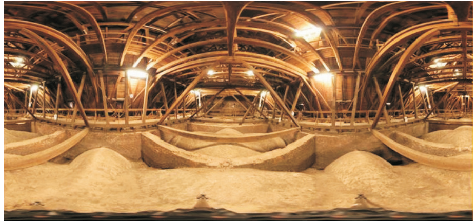
Panoramabild des Dachstuhls
